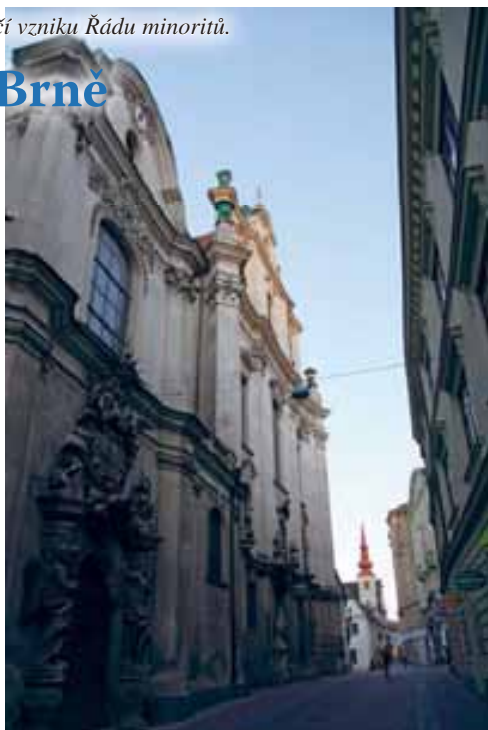
Kostel sv. Janů a Loreta v Brně. Na vrchu průčelí chybějí sochy tří archandělů, které je nutno restaurovat, stejně tak celou fasádu kostela. Foto: bB.
